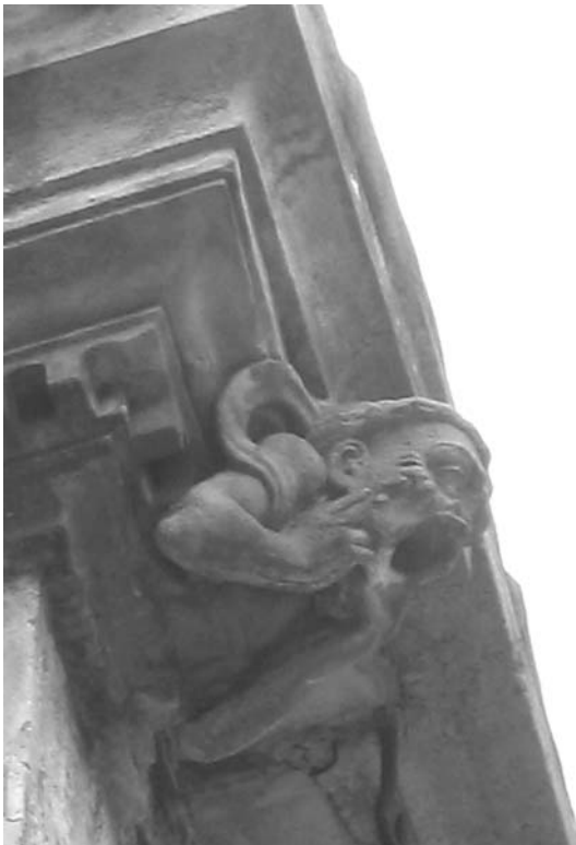
Detalle de la gárgola esculpida en el lateral trasero del palacio Arabio en Elorrio.
